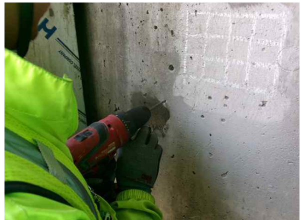
탄산화깊이 측정 현황
